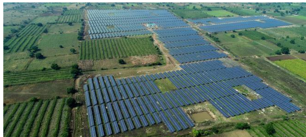
Figure 9 : Parc au sol, de TECHNIQUE SOLAIRE, en Inde à Maharashtra.
